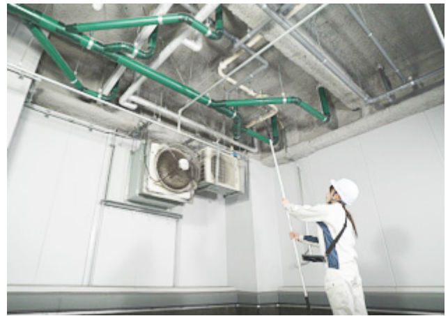
配管勾配測定器を使い配管の勾配角度を計測
