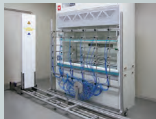
多点風速計による風速測定
