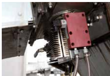
屋外の製造設備
