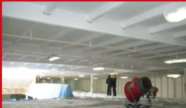
デッキの天井及び壁の結露防止
