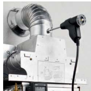
煙道にプローブを差し込みドラフト圧を測定
